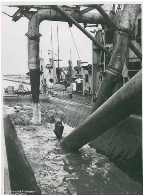
1954-55 Dragage pour la réalisation de l'écluse Baudouin entre l'Escaut et le Bassin du Canal, rive gauche © Stadsarchief Antwerpen (SAA) photo FOTO-HB#3675
